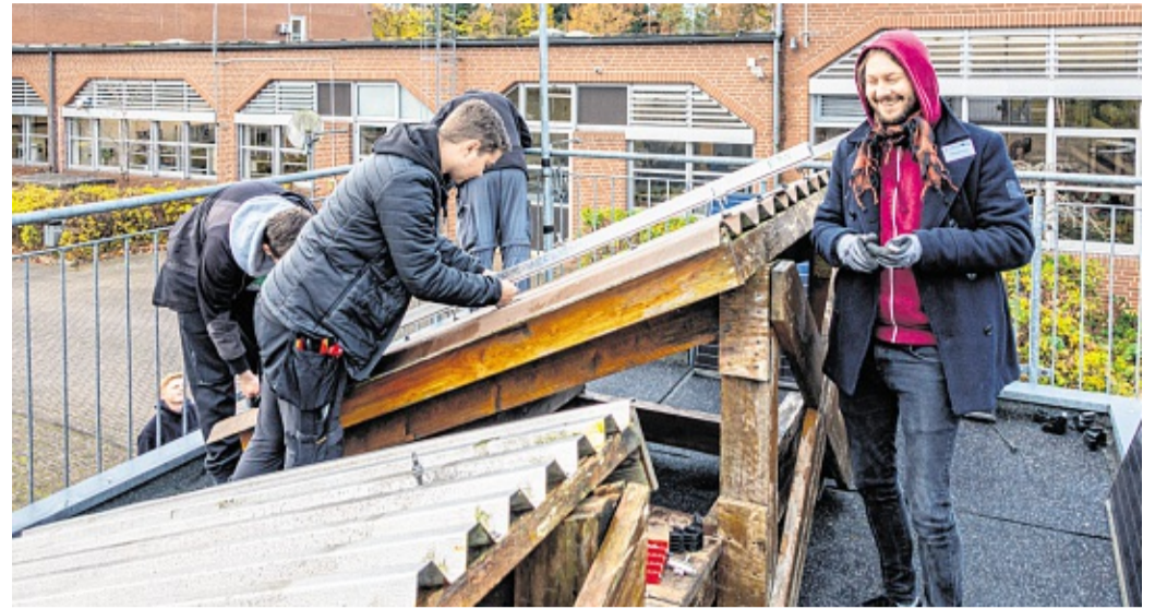
Der Aufbau einer Photovoltaik-Außenanlage war eines der Projekte, das die deutschen und dänischen Schüler gemeinsam erfolgreich gestalteten und bewältigten. Foto: Lars Stender/hfr
